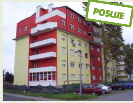
Nakon što je Filmar preuzeo upravljanje zgradom pokrenuta je obnova. Sve je uspješno realizirano u godinu dana.
