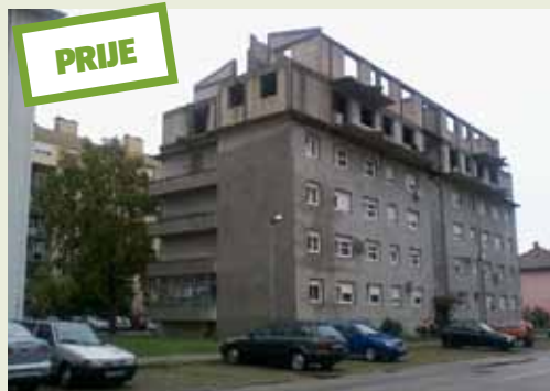
Stanari zgrade u ulici Stjepana Vukovića 3 u Varaždinu godinama su priželjkivali energetska obnovu svoje zgrade.
